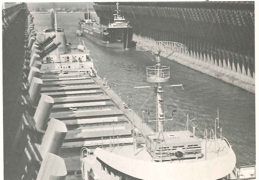
IRON ORE DOCK - ALLOWEZ
